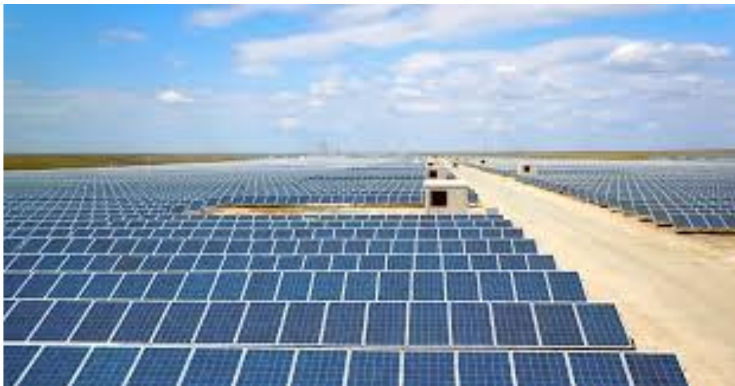
Рис. 1.1 – Кремниевые панели солнечной электростанции
