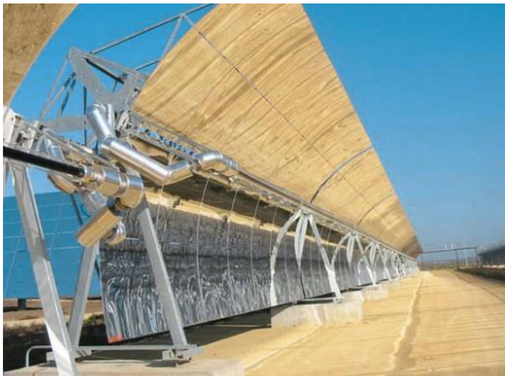
Рис. 3.7 – СЭС с параболическими концентраторами в Аргентине
